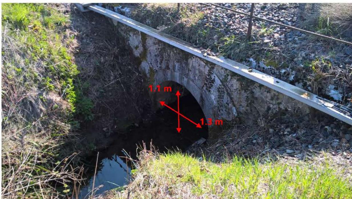
Figure 64 : Entonnement amont sous la voie ferrée
