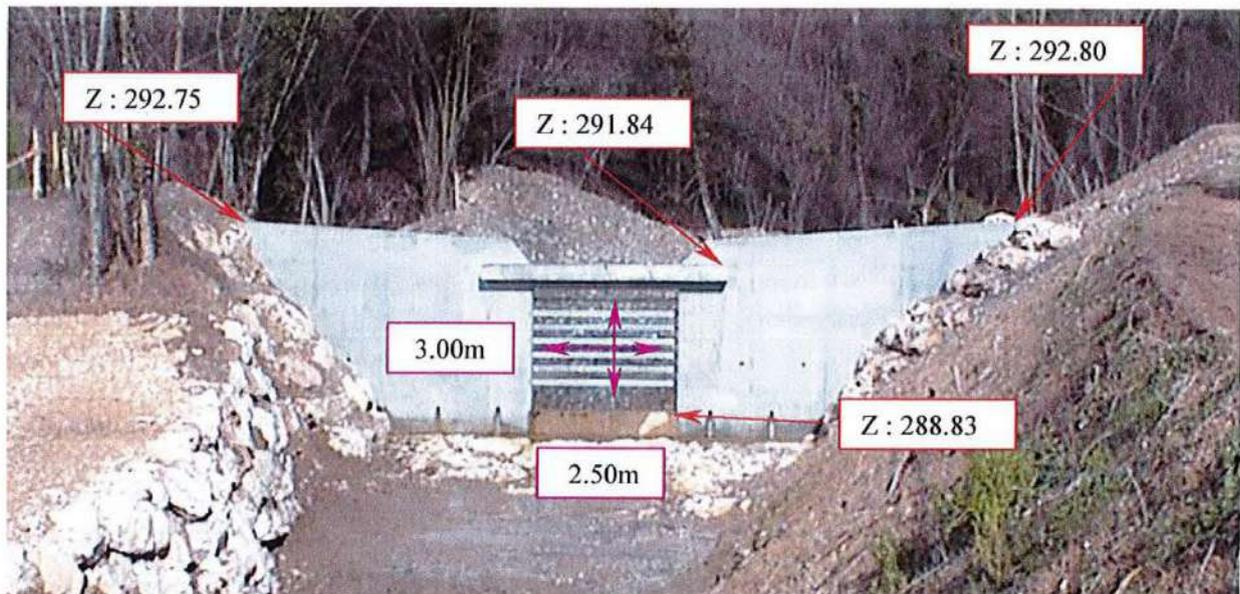
Figure 36 : Extrait du plan de récolement de l'ouvrage
