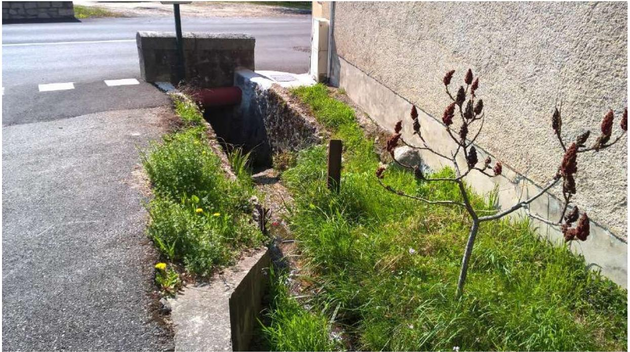
Figure 81 : Passage sous la RD 1092 vu de l'amont, le pieu à embâcles est visible en amont
