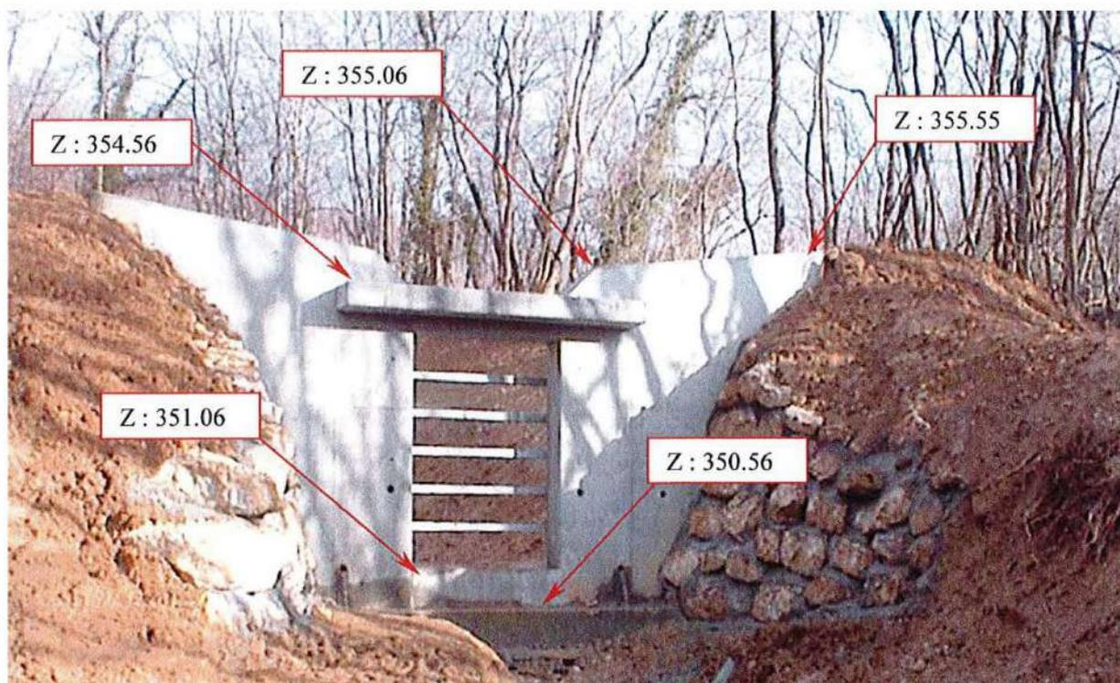
La combe est nettement plus élargie à l'amont de l'ouvrage par rapport au précédent barrage. Dans ces conditions, à hauteur d'ouvrage équivalente, la capacité de l'ouvrage est nettement plus importante. Elle est estimée à environ 2 500 m<sup>3</sup>.
