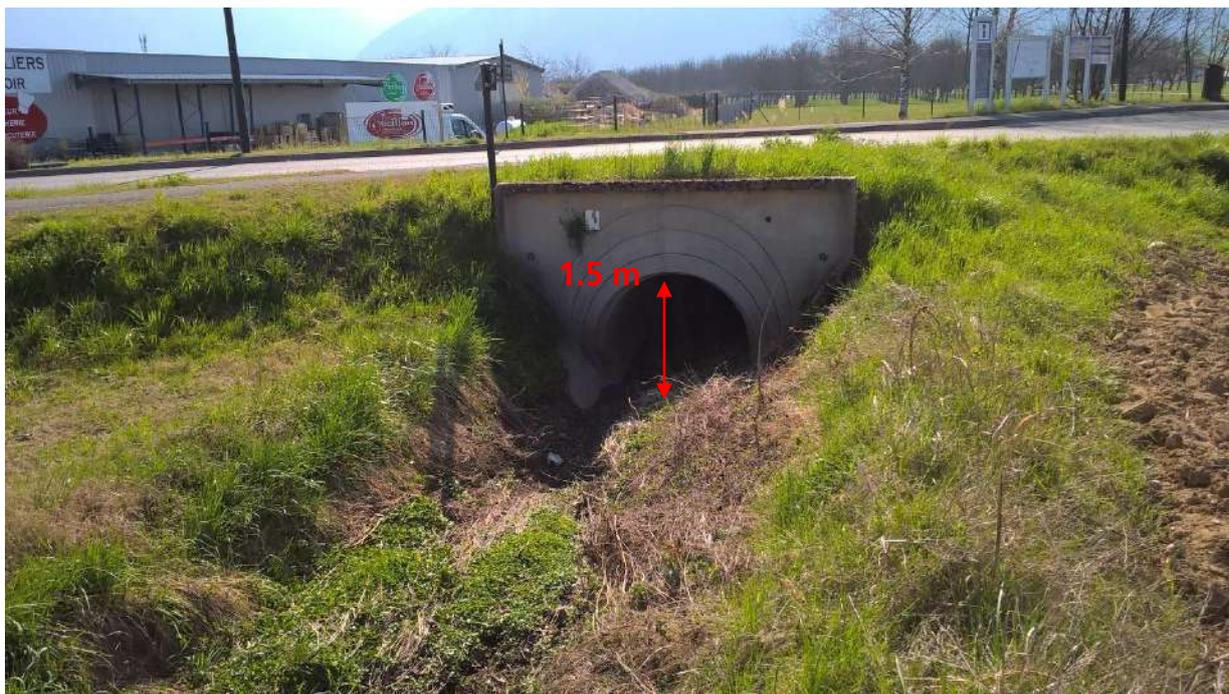
Figure 69 : Rétablissement hydraulique de la route de Gérifondière
