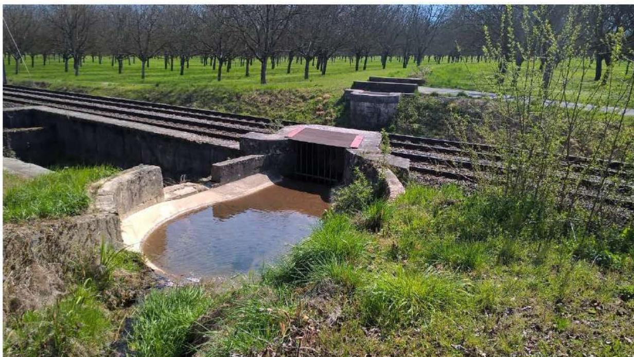
Figure 86 : Siphon sous la voie ferrée (section 1mx1m)
