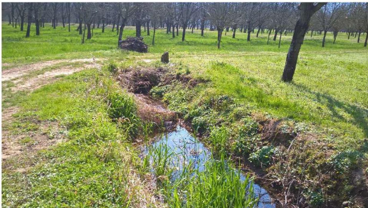
Figure 87 : Fin du lit et ouvrage d'infiltration
