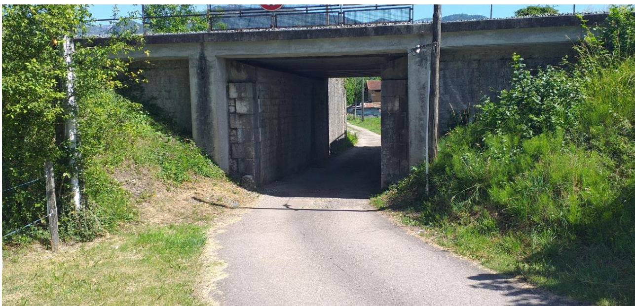
Figure 6 : Vue amont du rétablissement routier
